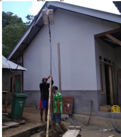
Gambar 4. Pemasangan Tiang Penyangga
