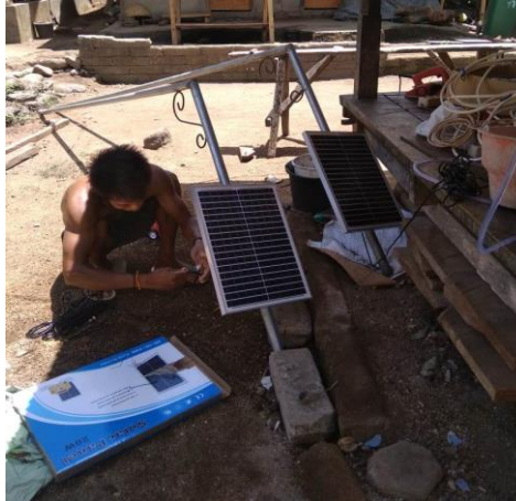
Gambar 3. Pemasangan Panel Sel Surya dan Lampu LED 12 V pada Tiang Penyangga
