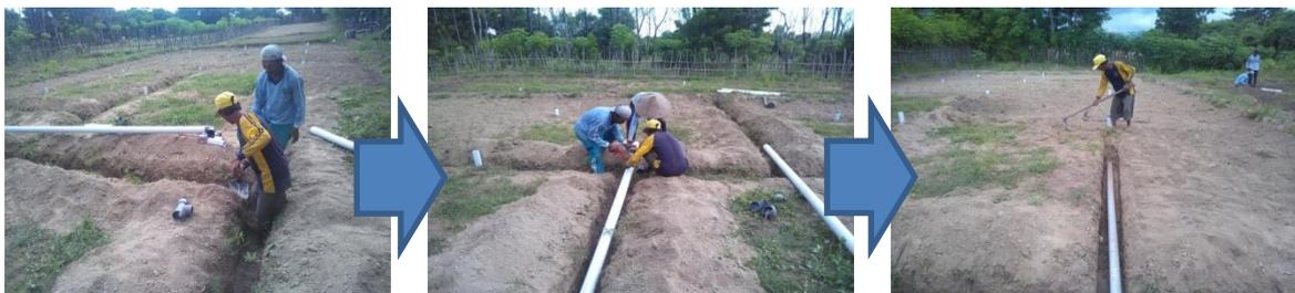
Gambar 4. Penyiapan jaringan leeb pipa
