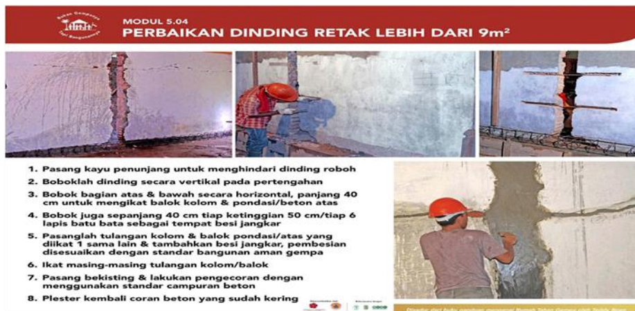
Gambar 4. Perbaikan dinding retak
