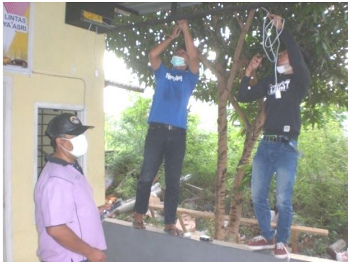
Gambar 2 Pemasangan dan uji coba instalasi catu daya listrik sel surya
